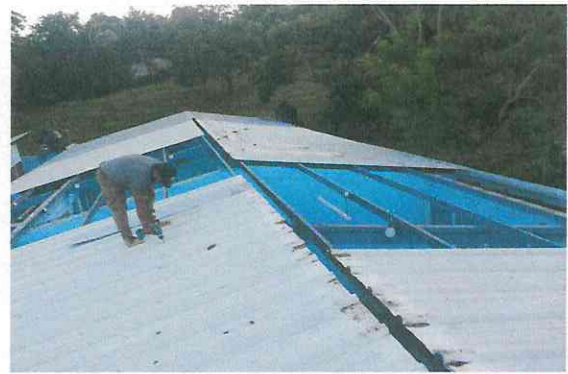
Foto 4: Levantamiento de 300 metros de lámina corrección de traslape e instalación nuevamente.
