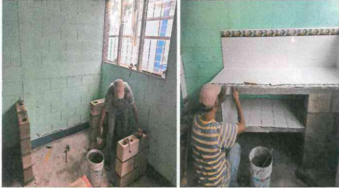
Foto1: Reconstrucción de Polletón de cocina, cambio de plancha y chimenea.
