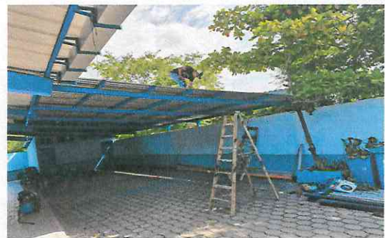
Foto 6: Instalación de estructura metálica y techo de lámina troquelada calibre 26 patio del establecimiento
