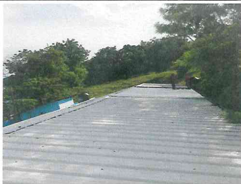
Foto 5: Instalación de 80 metros de lámina nueva troquelada calibre 26
