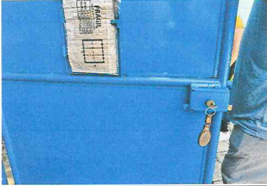
Foto 7: Mantenimiento de 5 puertas y portón de ingreso (Limpieza, soporte y pintura)
