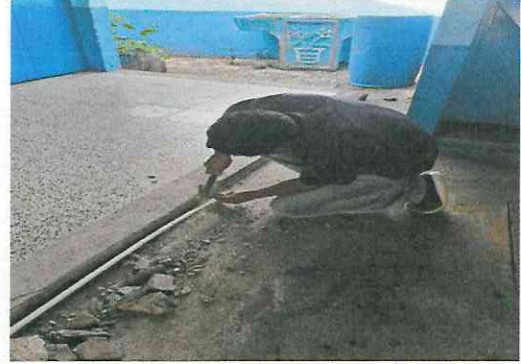
Foto 2: Sustitución y colocación de nueva tubería de la pila.
